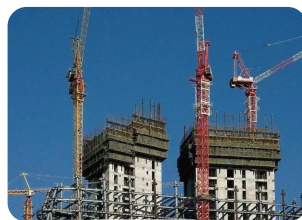
施工竣工测量
